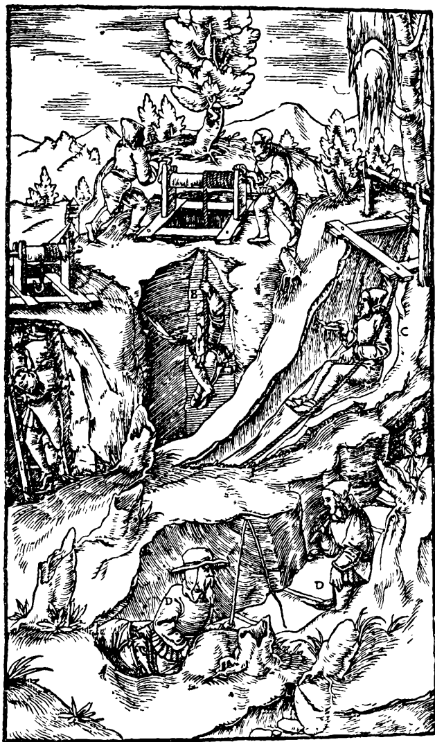
Горный промысел в XVI в. Из «Горной книги» Агри- колы, 1556 г. Различные системы шахт и способов спуска в них горняков. Один из горняков спускается в шахту при помощи ворота (слева).
